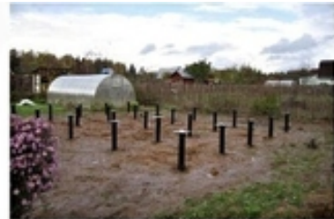
Свайно-винтовой фундамент для каркасного дома
