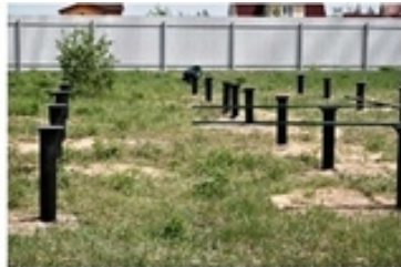
Свайно-винтовой фундамент для дома из профилированного бруса
