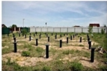
Свайно-винтовой фундамент для дома из профилированного бруса
