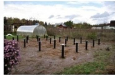
Свайно-винтовой фундамент для каркасного дома
