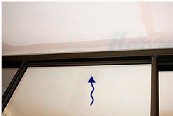
Установка верхнего направляющего рельса.
