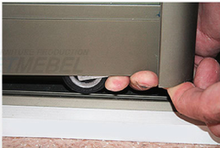
Установка нижнего направляющего рельса.
